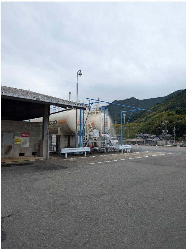
○写真上：散水作業
