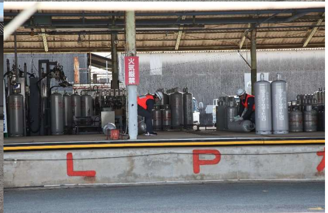
(ドローンによる被災状況の確認)
