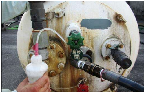
接続部のガス漏れ確認
