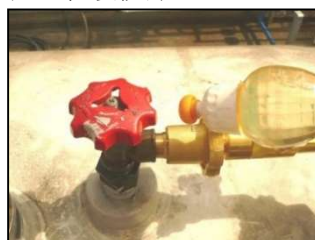
← 接続部のガス漏れ確認
