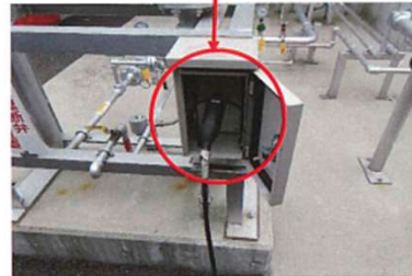
アースクリップを上下に挟み込む
