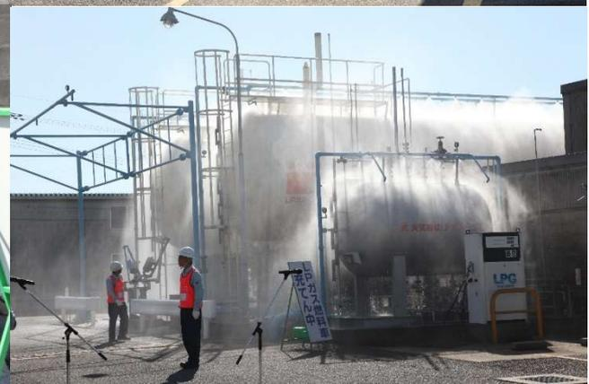
(3) 中核充填所稼働訓練：非常用発電機にて動力を確保
