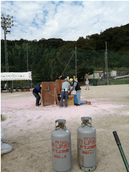
入浴施設の設置
