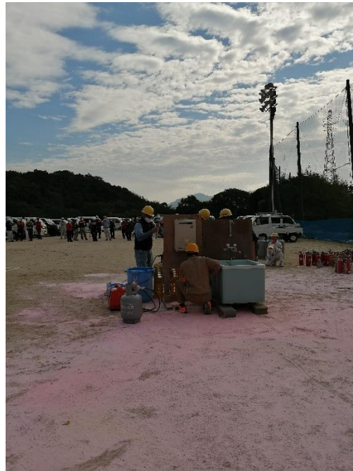
入浴施設の設置
