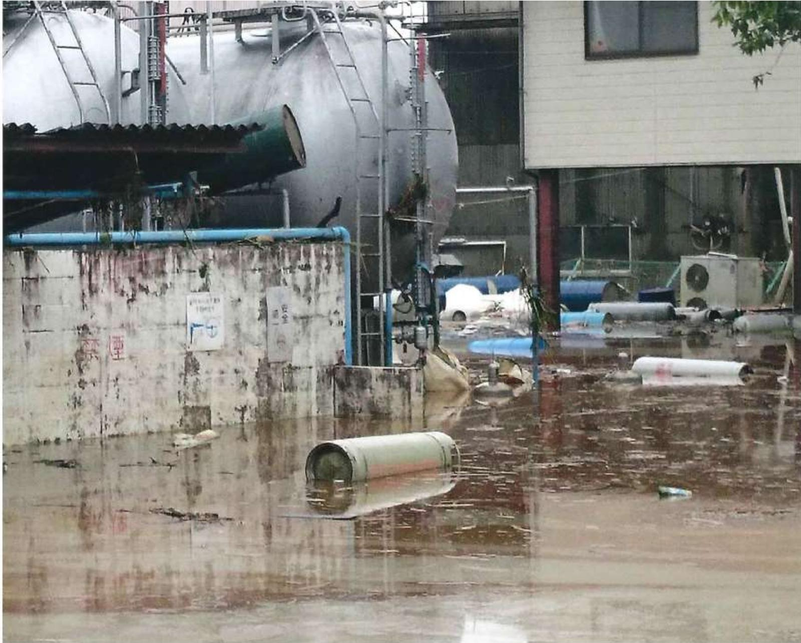
充填所のストレージタンク横の散水管には緑色のドラム缶が引っかかっている。この高さまで浸水したことを示す
