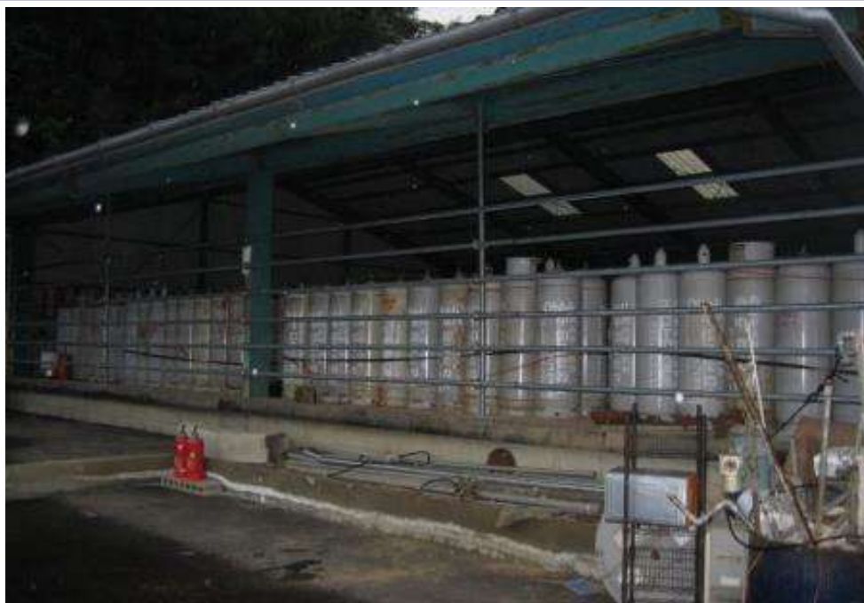
置場の周囲を鉄パイプで囲った例
