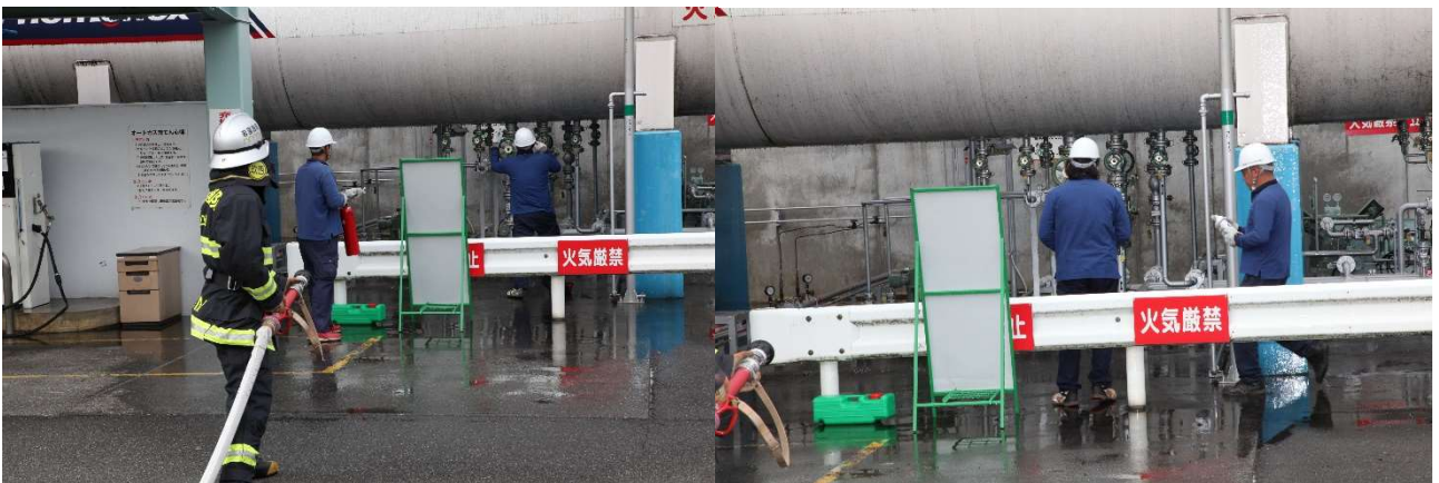
(漏洩箇所の応急措置)
